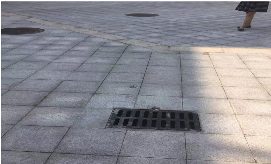
图 4-1 本项目雨水收集沟
