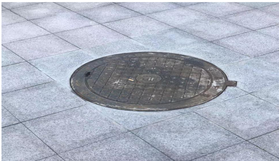
图 4-2 本项目污水收集沟
