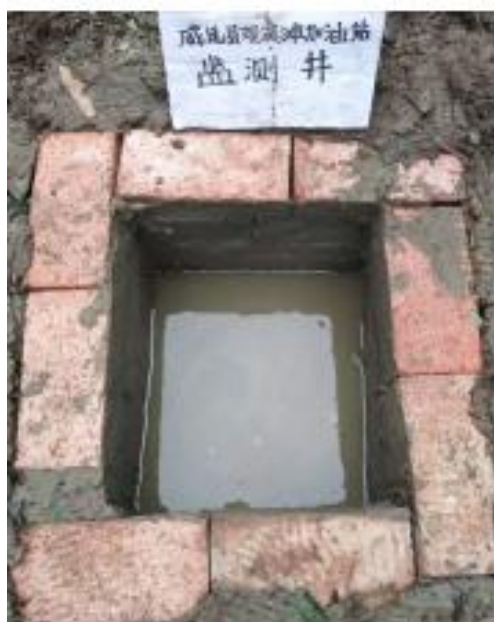
地下水水质检测井
